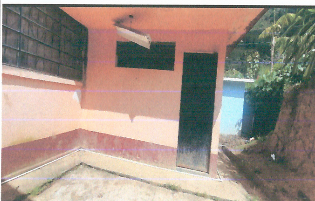
Foto 3: Mejoramiento y ampliación de servicios sanitarios
